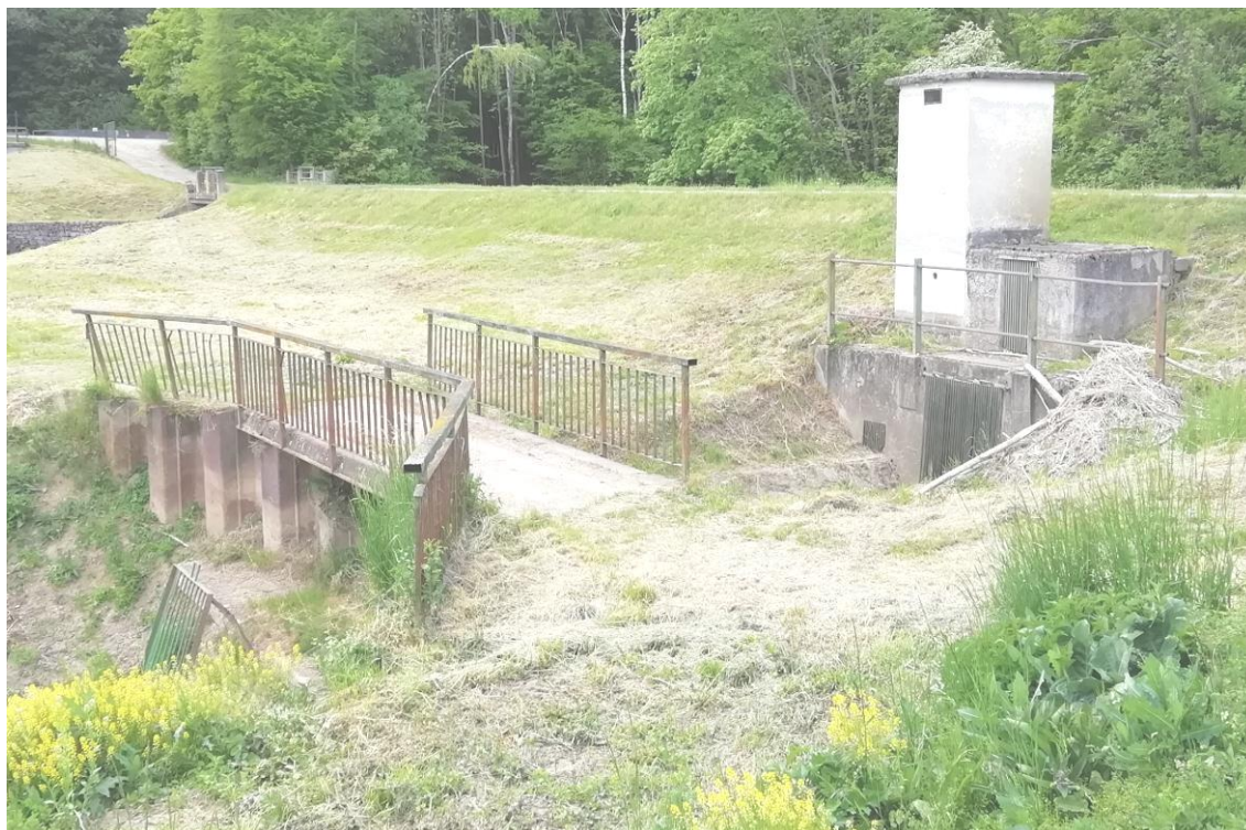
Obr. č.1 ... Výpustný objekt
