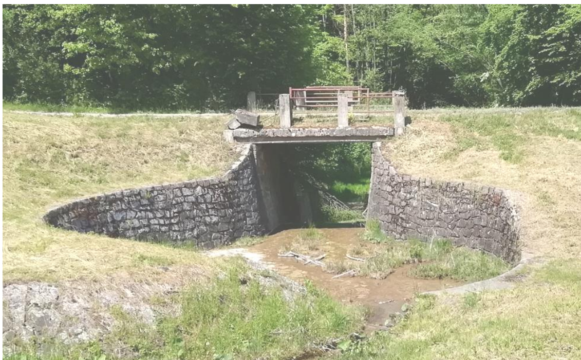
Obr. č.2 ... Bezpečnostní přeliv se sníženou přelivnou hranou a mostem
